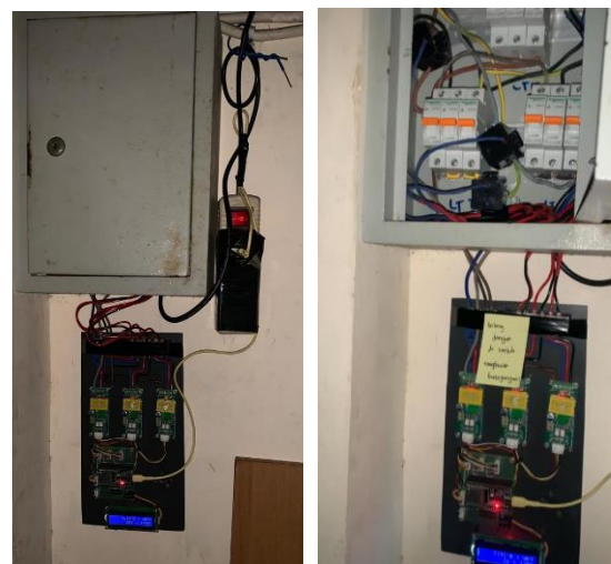
Gambar 4. Hasil Pemasangan Rangkaian di Panel
