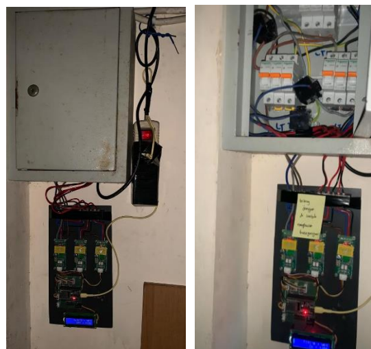
Gambar 4. Hasil Pemasangan Rangkaian di Panel
